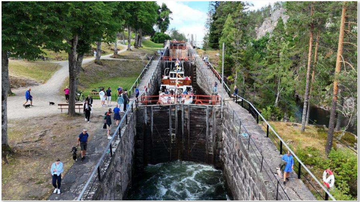
An der Treppe des Telemark-Kanals in Vrangfoss
